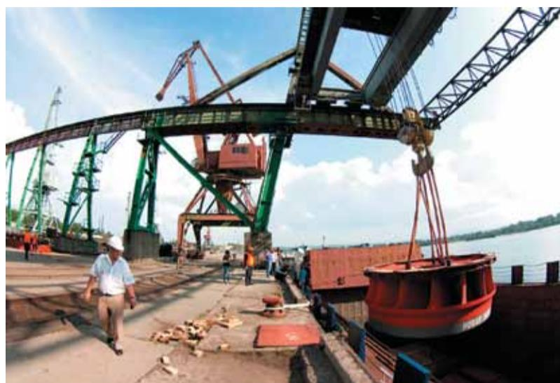
Енисея в 21,5 км от СШГЭС). После чего оборудование будет перегружено на специальный автотранспорт, который перевезет гидроагрегаты непосредственно на монтажную площадку Саяно-Шушенской ГЭС.
