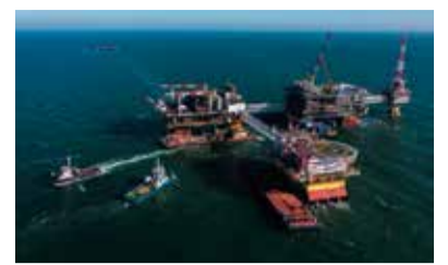
Общий вид объектов обустройства месторождения им. В. Филановского (осень 2014 г.)
