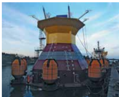
Опорный блок РБ перед транспортировкой завода «Красные Баррикады» на точку установки.
