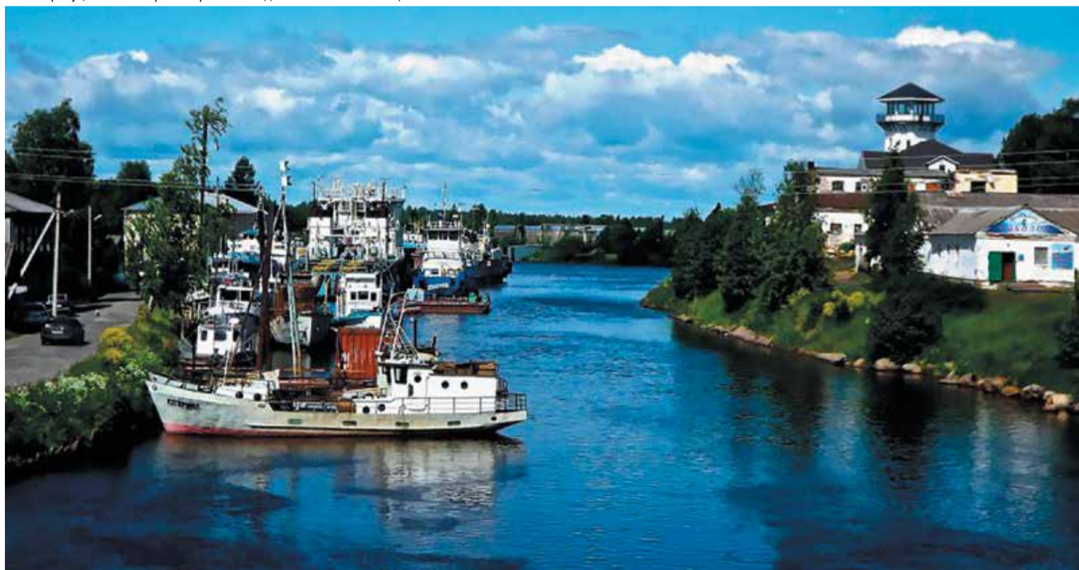
«Вытегорье — корабельная сторона». Фото Александра Паршунова
