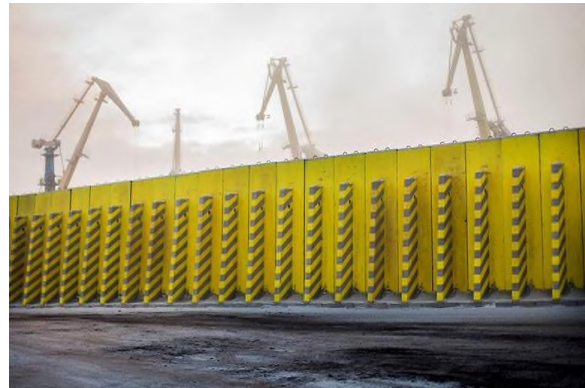
Рисунок 90 – Подпорные стенки для штабелей угля на складе
