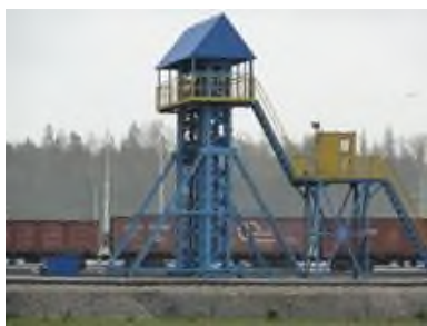
Бурильная установка для рыхления угля в вагоне
