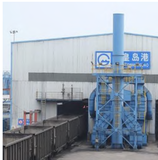
Рисунок 84 – Вид аспирационной установки для вагоноопрокидывателей
