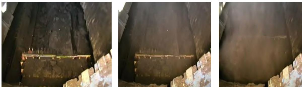
Рисунок 50 – Фазы работы дробильно-фрезерной машины. Организованный источник пыления
