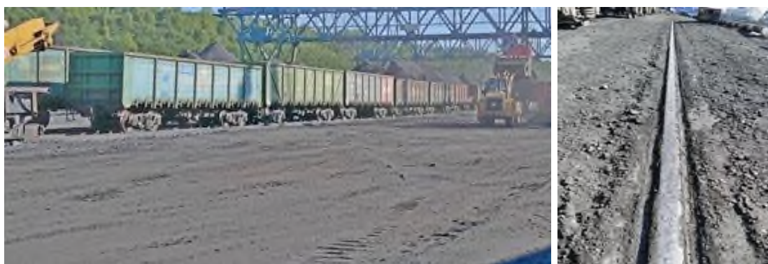
Рисунок 64 – Скопления пыли на покрытиях дорог, проездов и площадках
