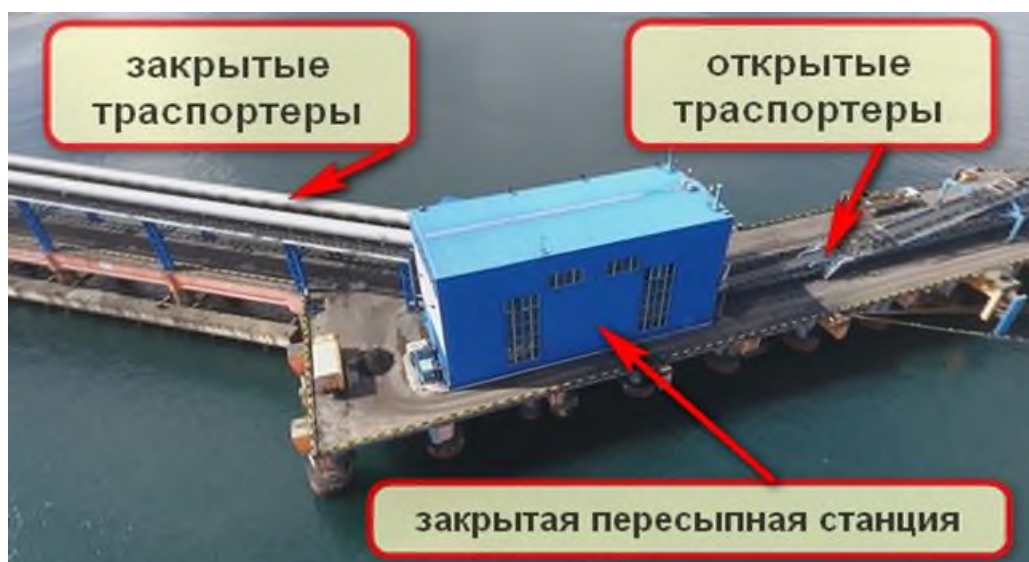
Рисунок 54 – ТКС с открытыми транспортерами являются линейными неорганизованными источниками пыления
