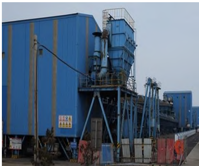
Рисунок 83 – Вид аспирационной установки для ПС
